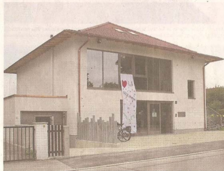
Große Fensterflächen kennzeichnen den neuen Kindergarten.
